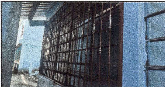
Foto 5: Sustitución de balcones de metal
