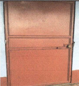
Foto 3: Sustitución de chapa
