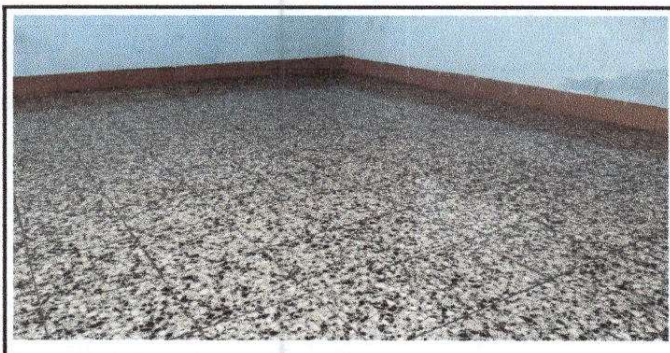
Foto 6: Sustitución de piso de granito
