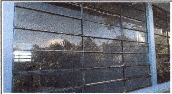
Foto 4: Sustitución de vidrios
